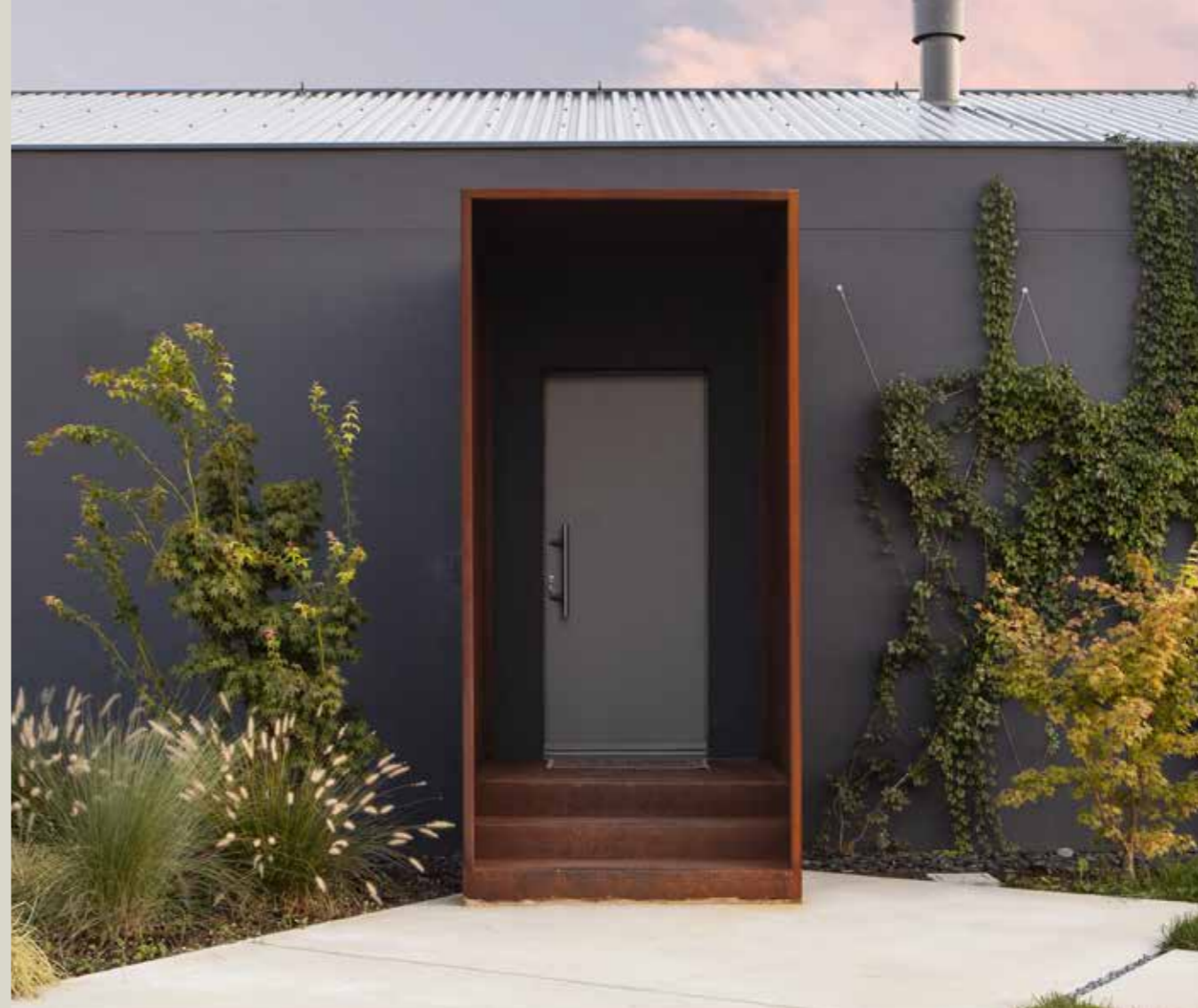
The Shell PassiveHouse: la porta d'ingresso Finstral dal design sobrio ed essenziale offre un ingresso confortevole in questa casa a basso consumo energetico a Cesena.
