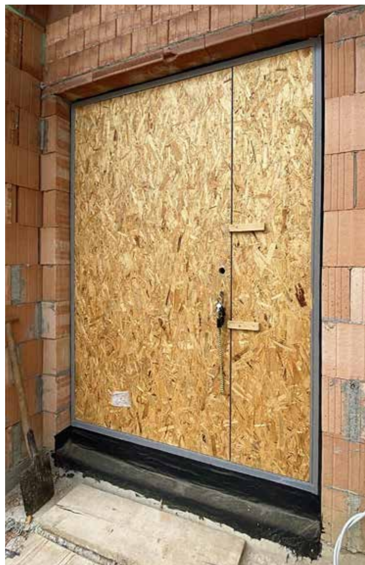
Una porta da cantiere con serratura semplice chiude provvisoriamente l'ingresso finché non viene montato il portoncino. Finstral fornisce su richiesta porte da cantiere premontate.
