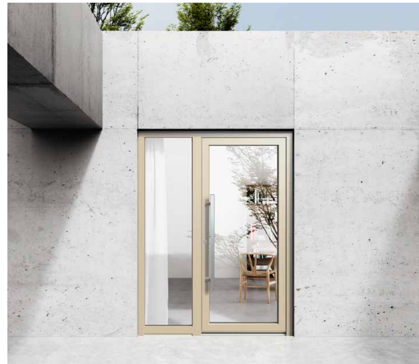
Le porte d'ingresso con ampie trasparenze andrebbero dotate di vetri a controllo solare, in grado di ridurre notevolmente l'apporto di calore.
